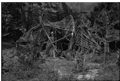
FIG. 6 Filme Macunaíma Tapera destruída/domínio do verde
